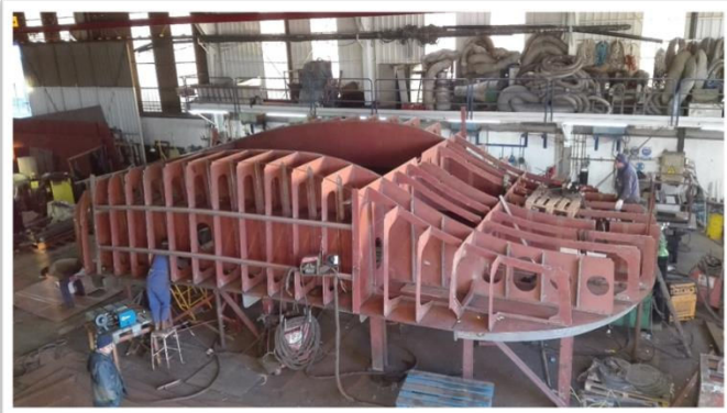
Construcción de pangas para atuneros en nuestras instalaciones.
