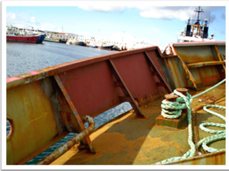
Reparación de amurada.
