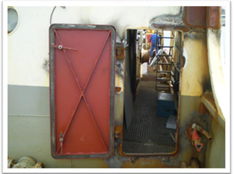
Construcción de Puerta estaca.
